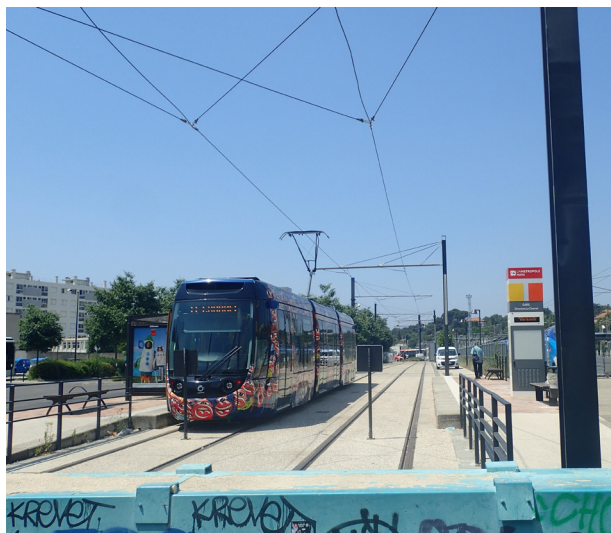
➤ Arrêt de tramway de la gare d'Aubagne
